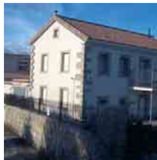
Edificio de la Dehesa Boyal, reformado por Apascovi para sus viviendas tuteladas
