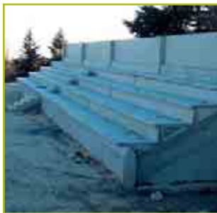
Gradas del nuevo campo
