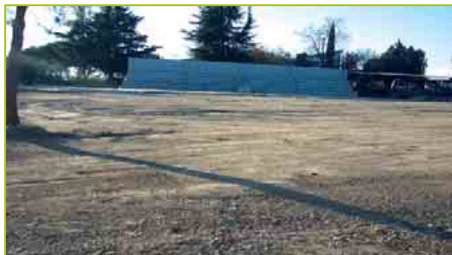
Terreno donde se está construyendo el nuevo campo de Minifútbol
