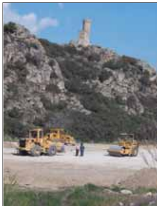
Máquinas trabajando en el futuro aparcamiento
